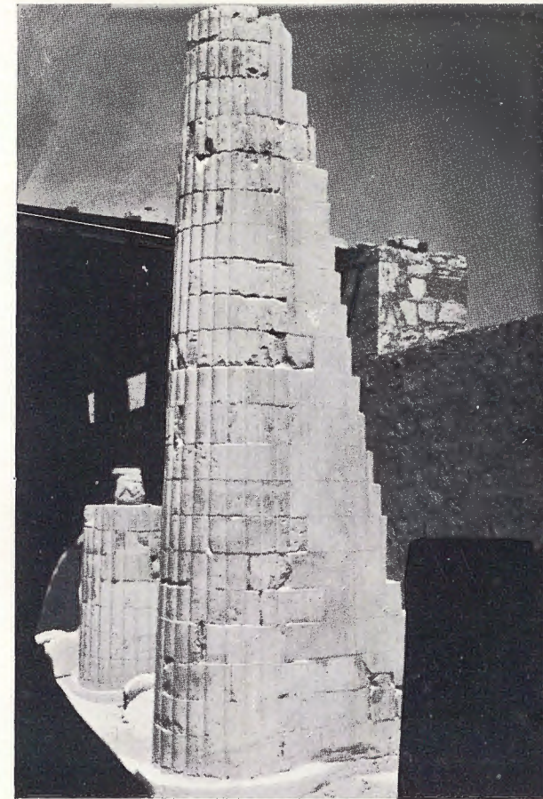
1. Colonne fasciculée restaurée.
